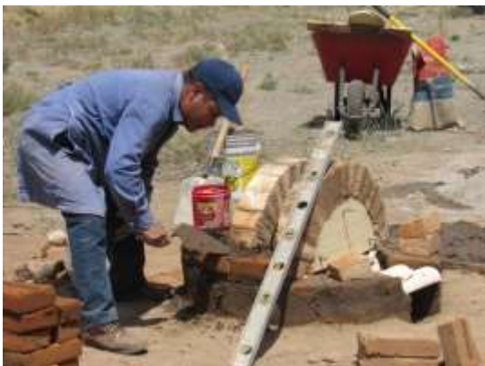
Imagen 49. Domingo terminando los arcos de la cámara de combustión del horno.
