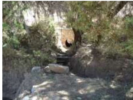
Imagen 8. Una de las tres alcantarillas de la carretera que surten la zona de reforestación del Campo Experimental La Cañada y las propuestas que se realizarían con los fondos que aportara el Acuerdo 10/08 del Rector General de la UAM. De esta alcantarilla parten dos ramales para sendos depósitos de agua.
