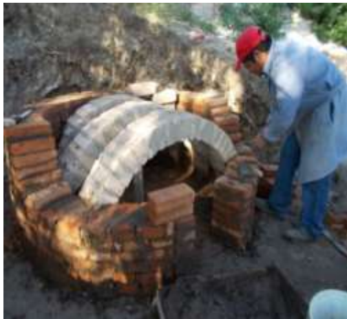
Imagen 34. Formado de los arcos de la cámara de fuego.
