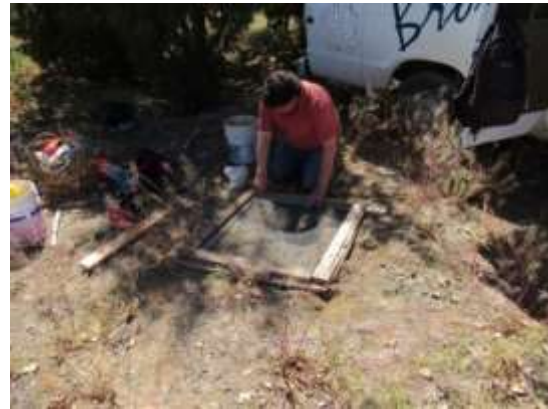
Imagen 44. El profesor Julián Hernández tamizando barro, parte de los materiales para la mezcla para unir los tabiques.
