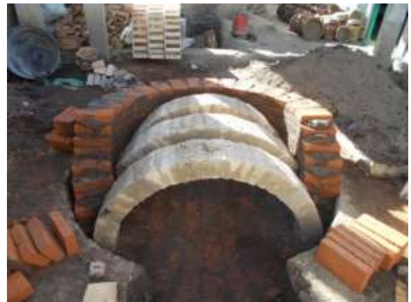
Imagen 39. Arcos y muro de la cámara de fuego.
