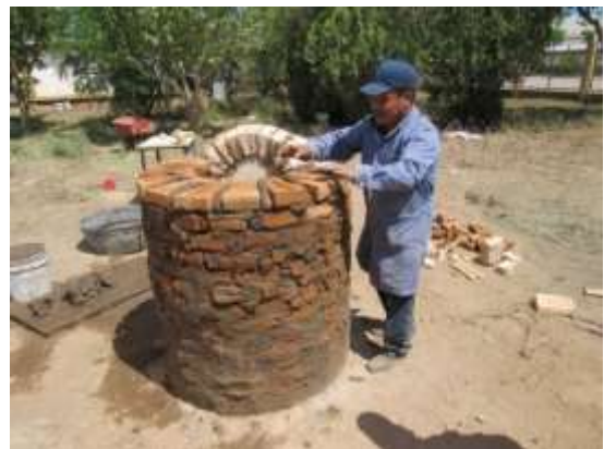
Imagen 51. Domingo concluyendo la cámara de estiba, el arco del dintel de la entrada se ve terminado.
