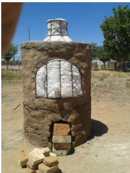
Imagen 53. Horno Tekol kilitzin tal y como lo dejamos, sólo faltaba la puerta de la cámara de combustión, que luego instaló el profesor Julián Hernández.
