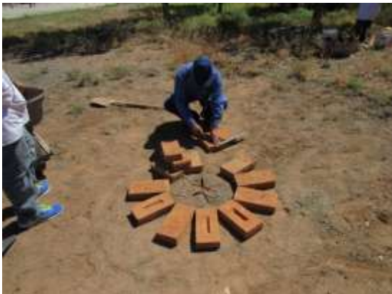
Imagen 43. El técnico constructor de hornos del CEA, Domingo Martínez R., ubicando los tabiques para formar la base del horno. Todos los tabiques fueron hechos en el CEA y enviados a Casas Grandes, Chihuahua.
