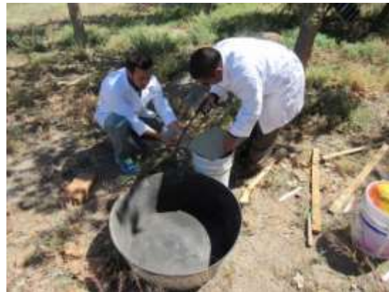
Imagen 45. Erik Ordaz y el ingeniero Moisés Ramírez recortando una lámina para formar un patrón con el cual dar forma al muro de tabique.
