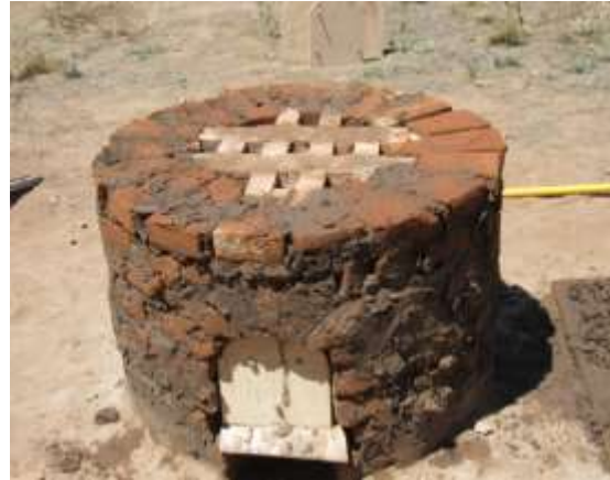
Imagen 50. La cámara de combustión del horno terminada con la parrilla, ésta soporta los productos en la quema y a través de ella asciende el fuego de la leña al consumirse en la parte inferior. Abajo, la tapa provisional del nicho de ingreso.
